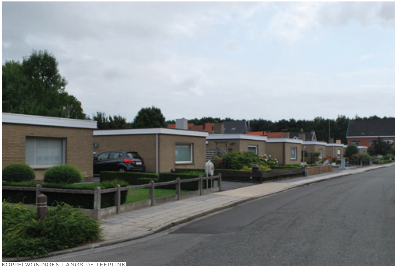
KOPPELWONINGEN LANGS DE TEERLINK
