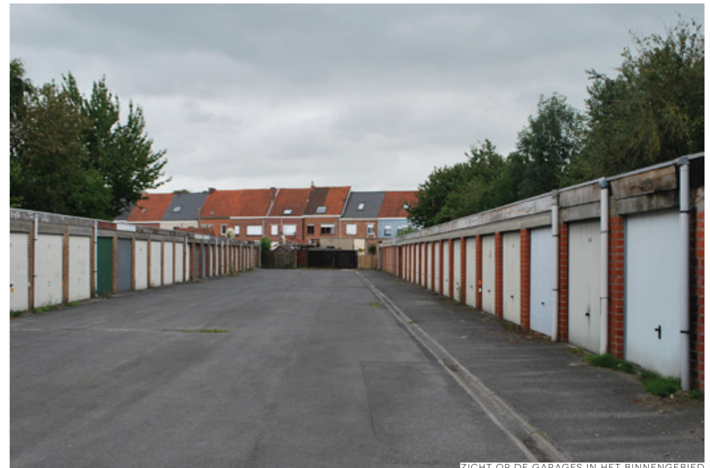
ZICHT OP DE GARAGES IN HET BINNENGEBIED
