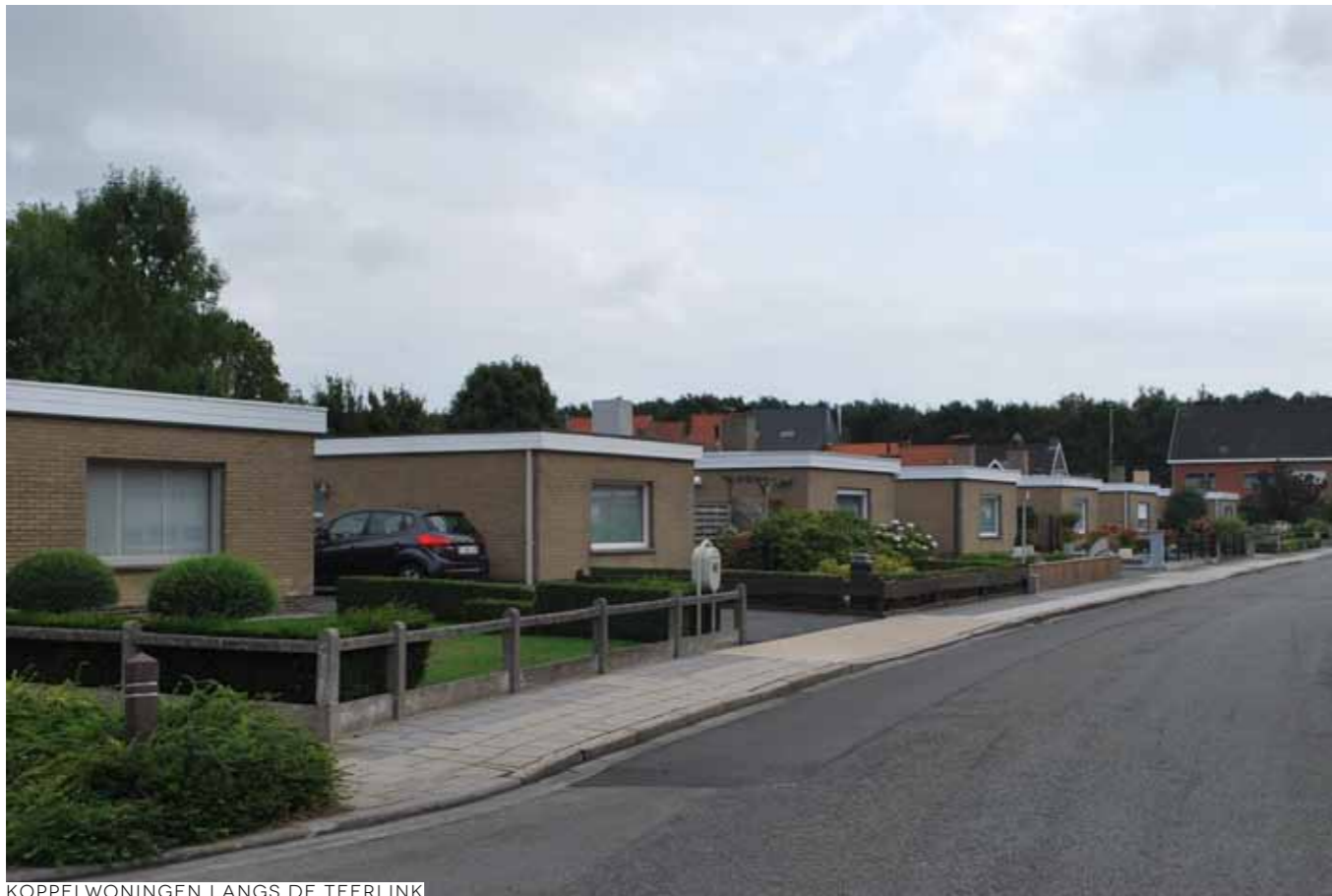
KOPPELWONINGEN LANGS DE TEERLINK
