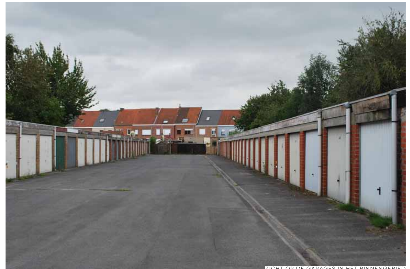
ZICHT OP DE GARAGES IN HET BINNENGEBIED
