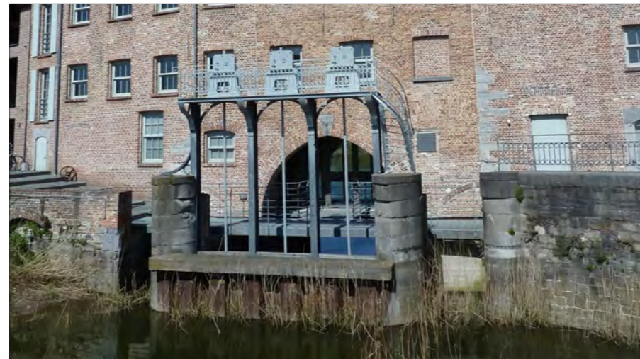
WATERINLAAT IN DE VOORGEVEL VAN DE BANMOLENS.
