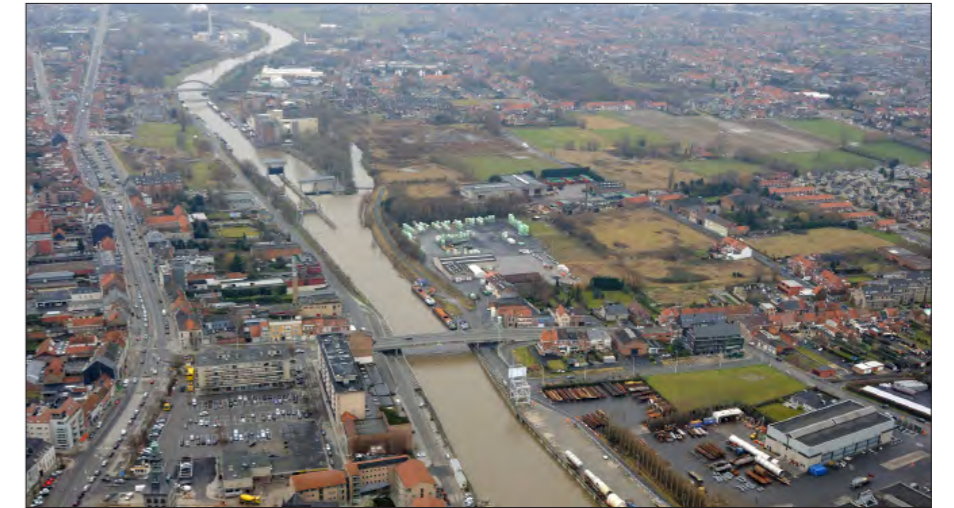
[VLUCHTFOTO 2009] ZICHT OP DE LEIE, MET OP DE VOORGROND HET MARKTPLEIN VAN HARELBEKE EN ACHTERAAN IN BEELD HET PLANGEBIED. RECHTS VAN DE STUW DE OUDE LEIARM, DE NOORDELIJKE BEGRENZING VAN HET PLANGEBIED.
