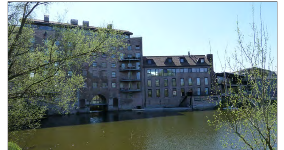
ZICHT OP DE ACHTERZIJDE VAN DE BANMOLENS, MET CENTRAAL DE UITLAAT VAN DE MOLEN. OP DE VOORGROND DE MOLENVIJVER.
