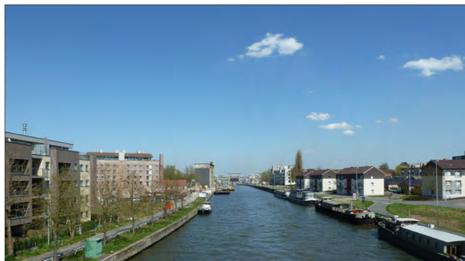
ZICHT OP DE BANMOLENS EN BLOEMMOLENS VANAF DE KUURNEBRUG. IN DE VERTE HET SLUIZENCOMPLEX.
