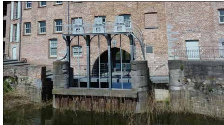
WATERINLAAT IN DE VOORGEVEL VAN DE BANMOLENS.
