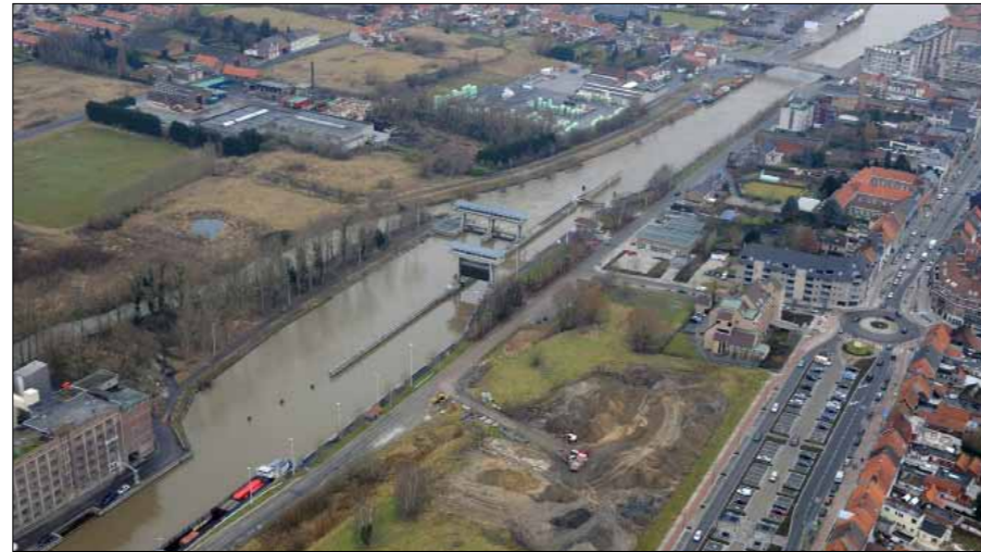
[VLUCHTFOTO 2009] ZICHT OP DE NOORDELIJKE TIP VAN HET MOLENEILAND EN HET SLUIZENCOMPLEX (RECHTS) MET DE STUW (LINKS). OP DE VOORGROND DE ONTWIKKELING WESTWIJK IN AANLEG.
