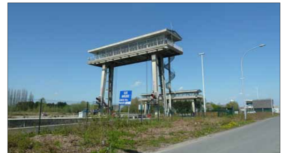
HET SLUIZENCOMPLEX MET DE HEFFPORTIEKEN.
