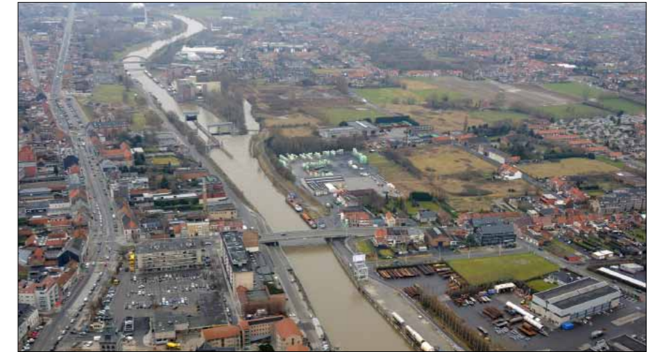
[VLUCHTFOTO 2009] ZICHT OP DE LEIE, MET OP DE VOORGROND HET MARKTPLEIN VAN HARELBEKE EN ACHTERAAN IN BEELD HET PLANGEBIED. RECHTS VAN DE STUW DE OUDE LEIEARM, DE NOORDELIJKE BEGRENZING VAN HET PLANGEBIED.
